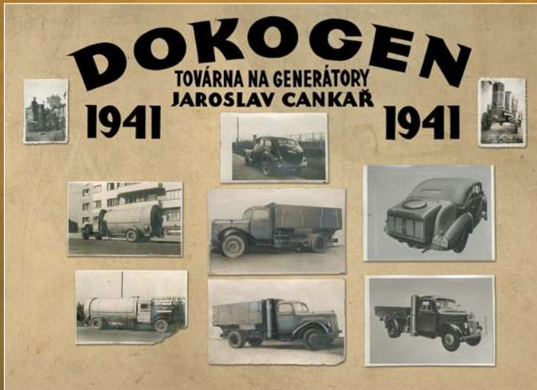
Виробництво і монтаж генераторів деревного газу «ДОКОГЕН»
