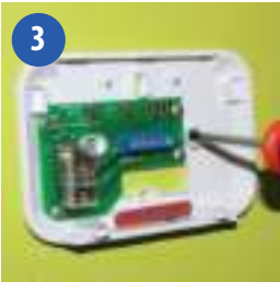
Прикрутите заднюю панель приемника к стене с помощью фитингов, поставляемых в комплекте.
