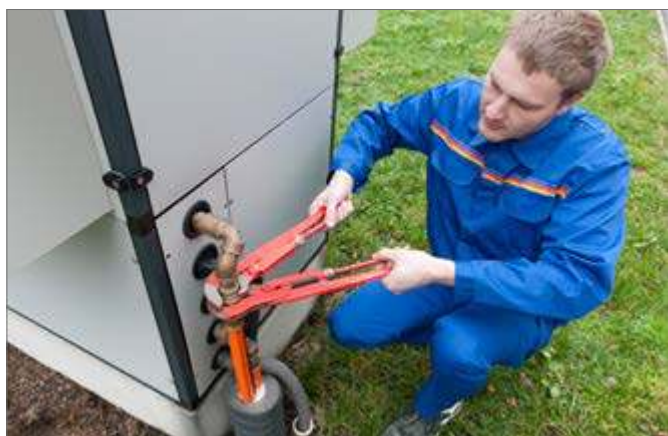
Рис. 4-17 Присоединение теплового насоса
