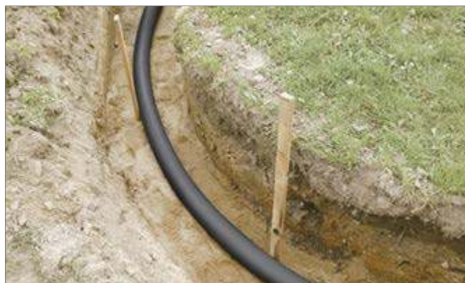
Рис. 7-15 Изменение направления без частей формы.
