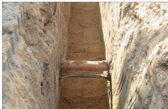
Рис. 7-2 Дно траншеи с опорой для трубы
