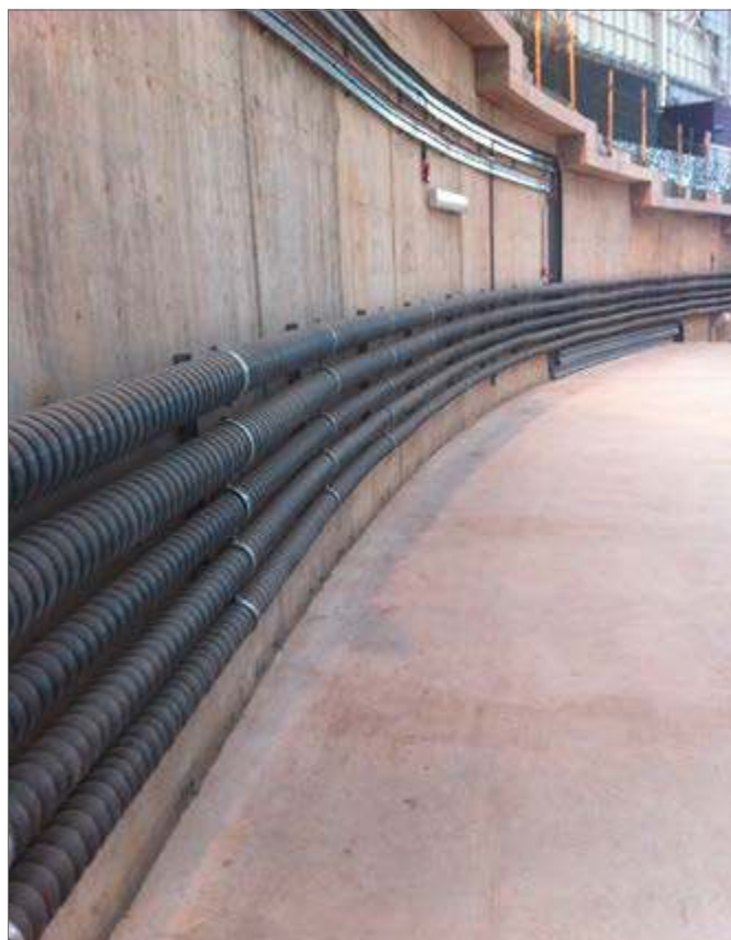
Рис. 7-20 Пример монтажа на стене / свободной прокладки
