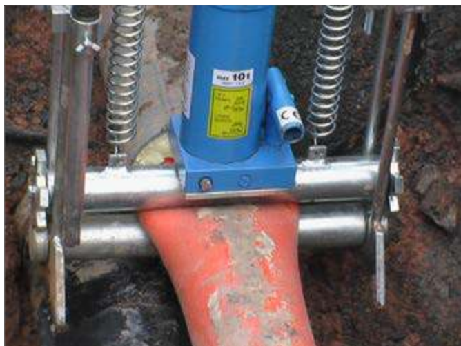
Рис. 7-21 Пережатие внутренней трубы UNO
