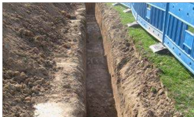
Рис. 7-1 Подготовленное дно траншеи
