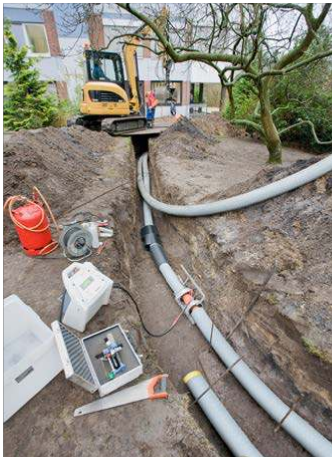
Рис. 4-11 FUSAPEX – соединение электросварными муфтами на практике
