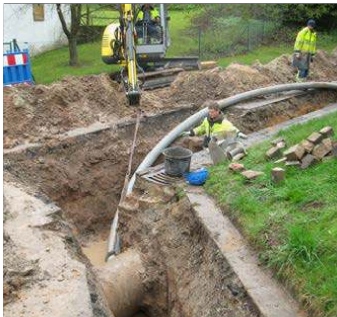
Рис. 7-16 Простая прокладка гибким трубопроводом
