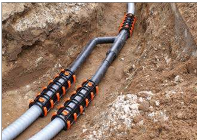
Рис. 4-27 Монтаж разветвителя на практике
