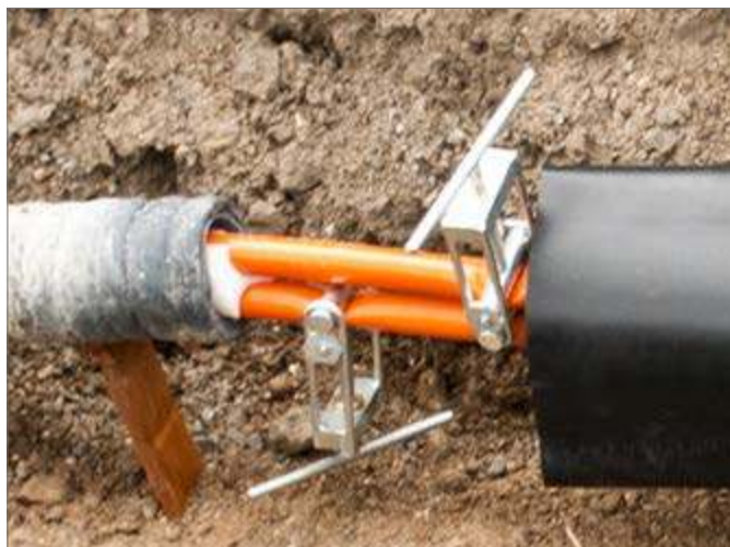
Рис. 7-22 Пережатие внутренней трубы DUO
