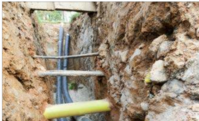
Рис. 7-14 Прокладка под пересекающимися трубопроводами
