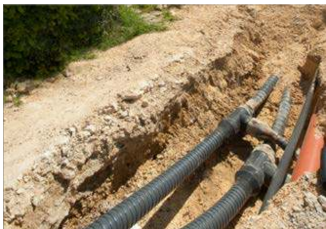
Рис. 7-4 Прокладка открытым методом в траншее
