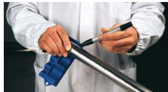
**Рис. 18 Обозначение глубины введения трубы в
