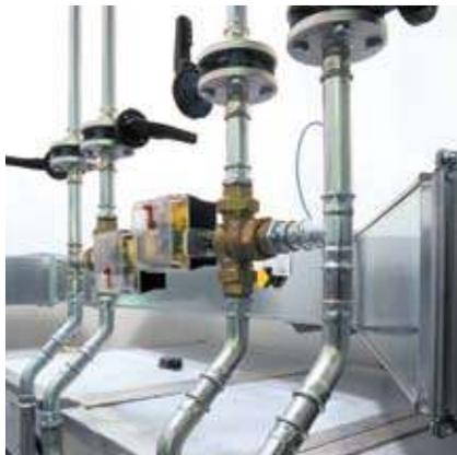
Рис. 11 Steelpres - Вода охлажденная
