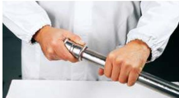
Рис. 21 Вставка трубы в пресс-фитинг
