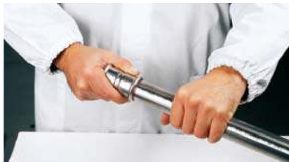
*Рис. 21 Вставление трубы в пресс-фитинг*
