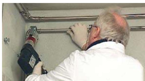
Рис. 22 Выполнение опрессовки
