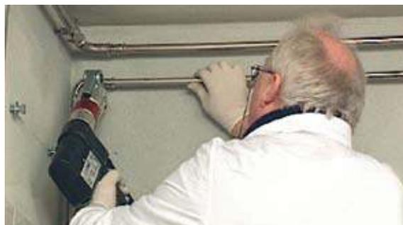
*Рис. 22 Выполнение опрессовки*
