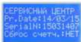
Рис. 31 – Вывод служебной информации об оборудовании
