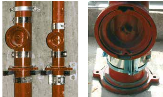
В закрытых системах установки опор трубопроводов не требуется
