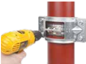
Усиливающий хомут должен быть расположен таким образом, чтобы центры закрывающих частей соединителя находились в выемках и чтобы кончики зажима находились на трубе. Две половинки зажима с 4-мя винтами необходимо соединить, не затягивая их.
