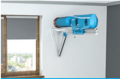
АЛМАЗНИМ БУРІННЯМ ВИСВЕРДЛЮЄМО ОТВІР ПОТРІБНОГО ДІАМЕТРУ
