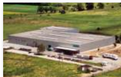
Производственно-логистический центр SANHA, Легница, Польша
